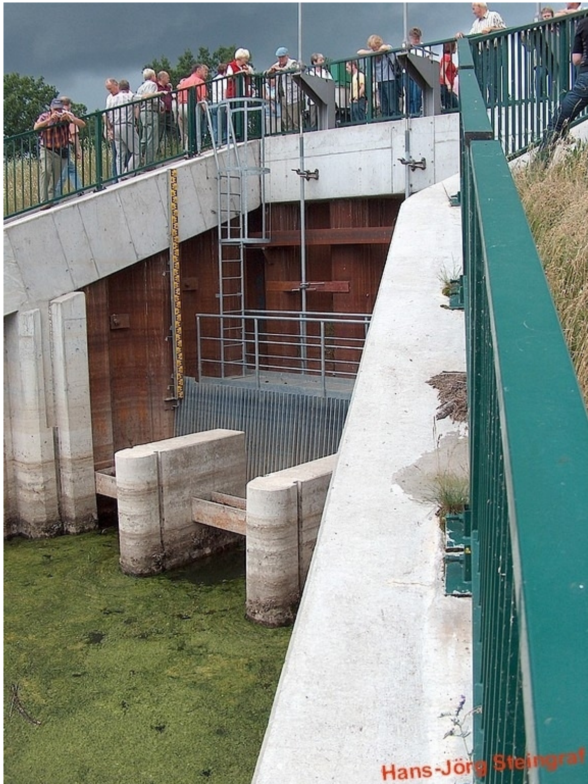
Bild 4: Bewässerungseinlaufbauwerk bei Reitwein
