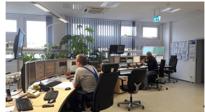
Zentrale Leitwarte der FWV Elbaue-Ostharz GmbH im Wasserwerk Torgau-Ost
