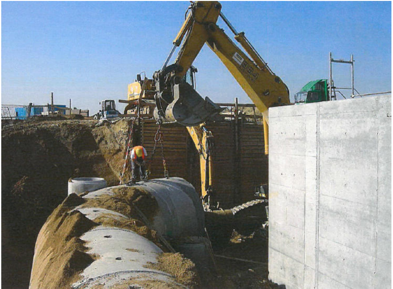
Abbildung 3: Bau eines Sammlers auf dem Flughafengelände [Quelle: Mitteldeutsche Airport Holding]
