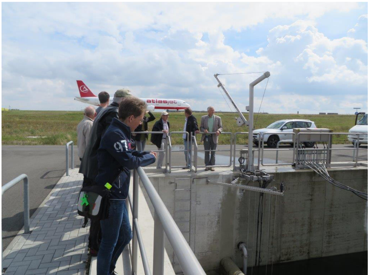
Abbildung 1: Teilnehmer an einem Entwässerungsbauwerk mit Steuerung
