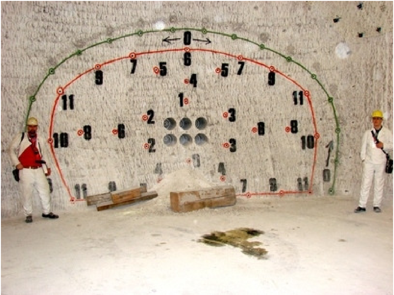
Abb.3 : Musterbeispiel für eine vorbereitete Sprengung
