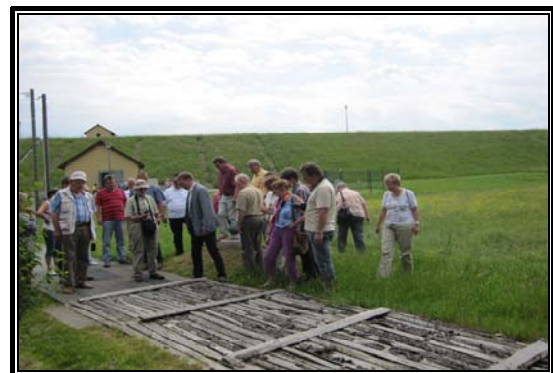
Bild 5: Grubenschwartenabdeckung einer Rösche am Großhartmannsdorfer Teich
