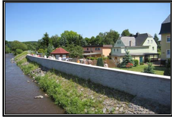
Bild 3: Hochwasserschutz an der Flöha
