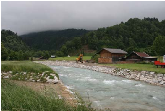
Bild 2: Überleitung der Kanker in die Partnach
